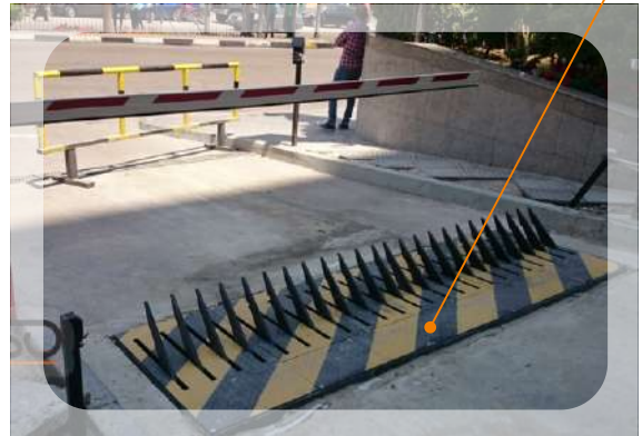
Погружной Tire-Killer в комплекте со шлагбаумом
