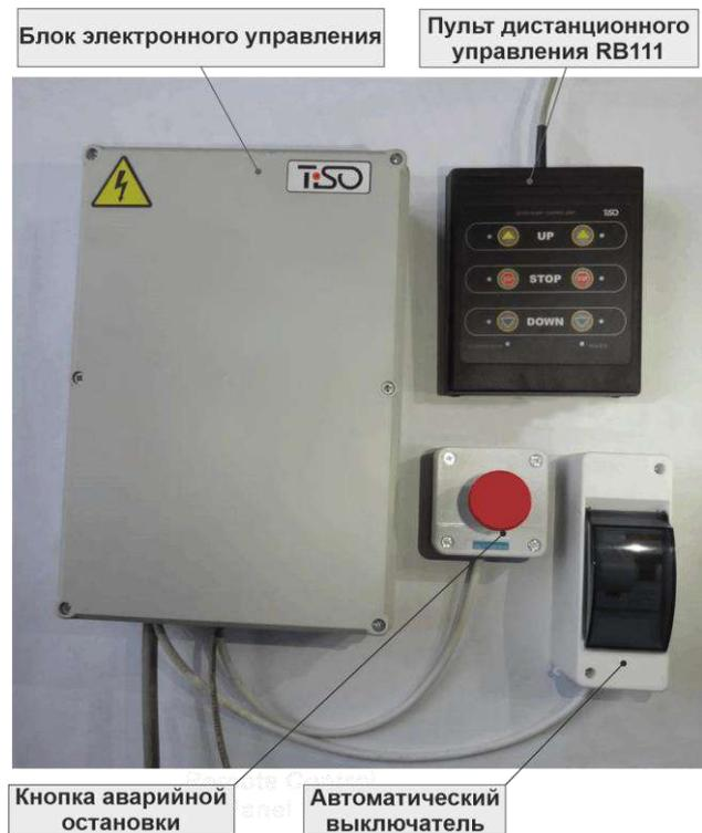
Рис. 8 - Блок управления с пультом дистанционного управления RB111, кнопкой аварийной остановки и выключателем питания.
