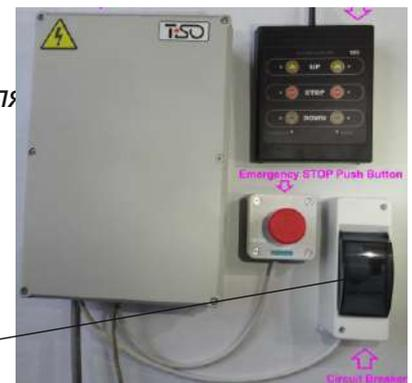
9.3.6 Электрооборудование болларда должно быть заземлено. Значение сопротивления между шиной заземления и каждой доступной металлической нетоковедущей частью корпуса электрооборудования болларда не должно превышать 4 Ом.
