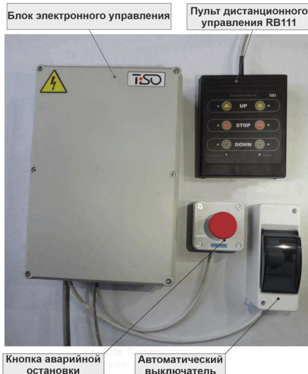
Рис.8 - Блок управления с пультом дистанционного управления RB111, кнопкой аварийной остановки и выключателем питания.
