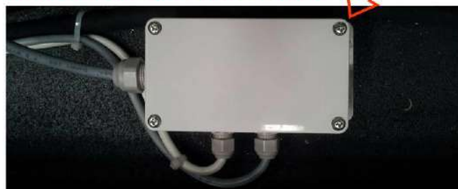
Рис. 17 - Проверка герметичности ревизионной электрической соединительной коробки блокиратора.
